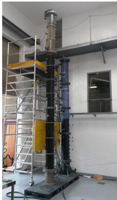
Abbildung 25 Festbettreaktor als Kolonne mit strukturierter Wabenpackung in der Versuchshalle der ARA Neugut. Die Packungshöhe beträgt 3.1 m. Gesamtbauhöhe der Kolonne ist rd. 6.20m. Rechts neben der Festbettkolonne die GAK-Filtration 3. Beide Systeme besitzen am Fuss der Kolonnen einen Polsterraum bzw. Fussstück, welches mit Ablaufregelventil und Anschlussstutzen für Druckluft und Brauchwasser zur Rückspülung ausgestattet sind. Die Festbett-Kolonne als auch der GAK-Filter wurden von der Firma Wabag zur Verfügung gestellt.
